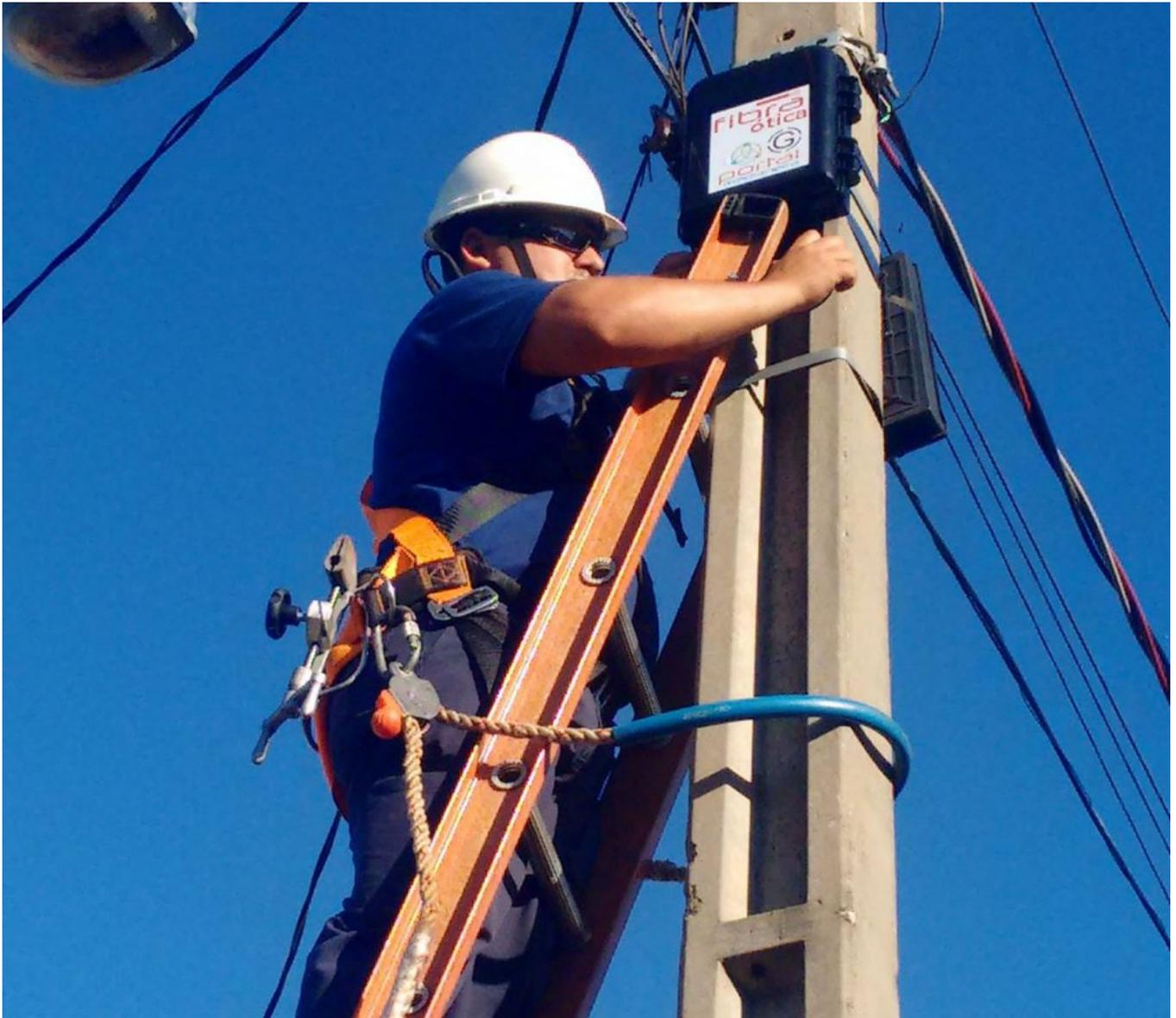
Parei o meu projeto de provedor FTTH em 12 caixas, 12 postes, ou 12 CTOs, pois, esse tipo de cabo de fibra óptica é um cabo de 12, e em cada uma dessas 12 CTOs eu irei colocar uma posição. Isso significa que em cada uma dessas 12 posições do DIO irá existir uma CTO. Cada um dos 12 postes vira uma posição no DIO.
